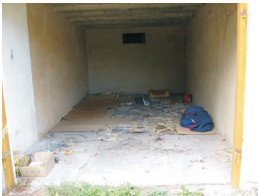
Obr. 5.11 Někdy k přespání poslouží i opuštěná garáž. Improvizovanou postel tvoří papírové kartony z rozložených krabic.
